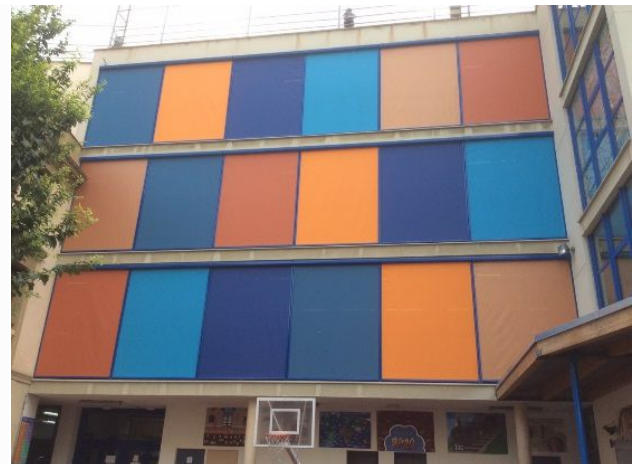
Fachada Mediterránea. (Fachada Dinámica Somfy)
